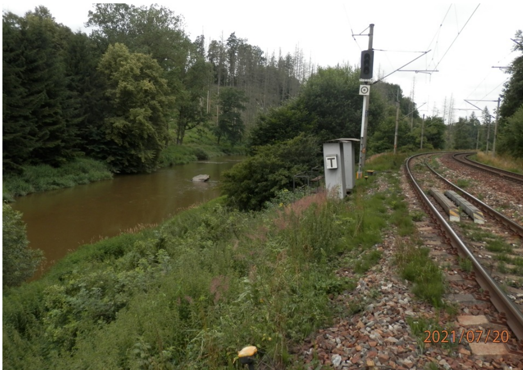
Obr. 11 Deformace svahu násypu u koleje č. 1 v km cca 237,370 nad řekou
