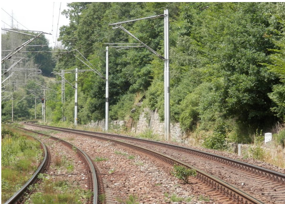
Obr. 10 Svah odřezu u koleje č. 2 v km cca 237,200-300 se zárubní zdí v patě
