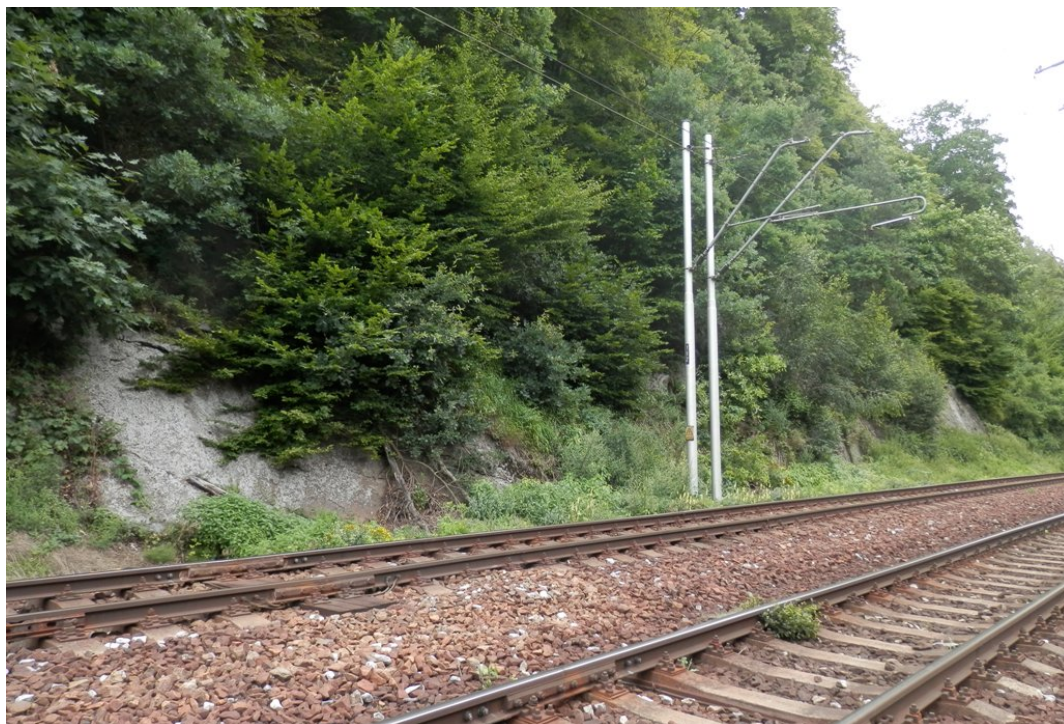
Obr. 13 Zvětralá pararula v odřezu u koleje č. 2 v km cca 238,000
