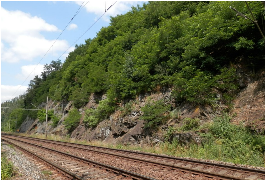
Obr. 9 Zvětralá pararula v odřezu u koleje č. 2 v km cca 236,700-800 (částečná sanace)
