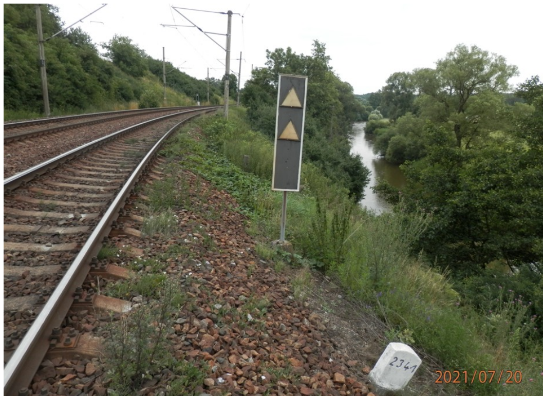
Obr. 2 Deformace svahu násypu u koleje č. 1 v km 234,100
