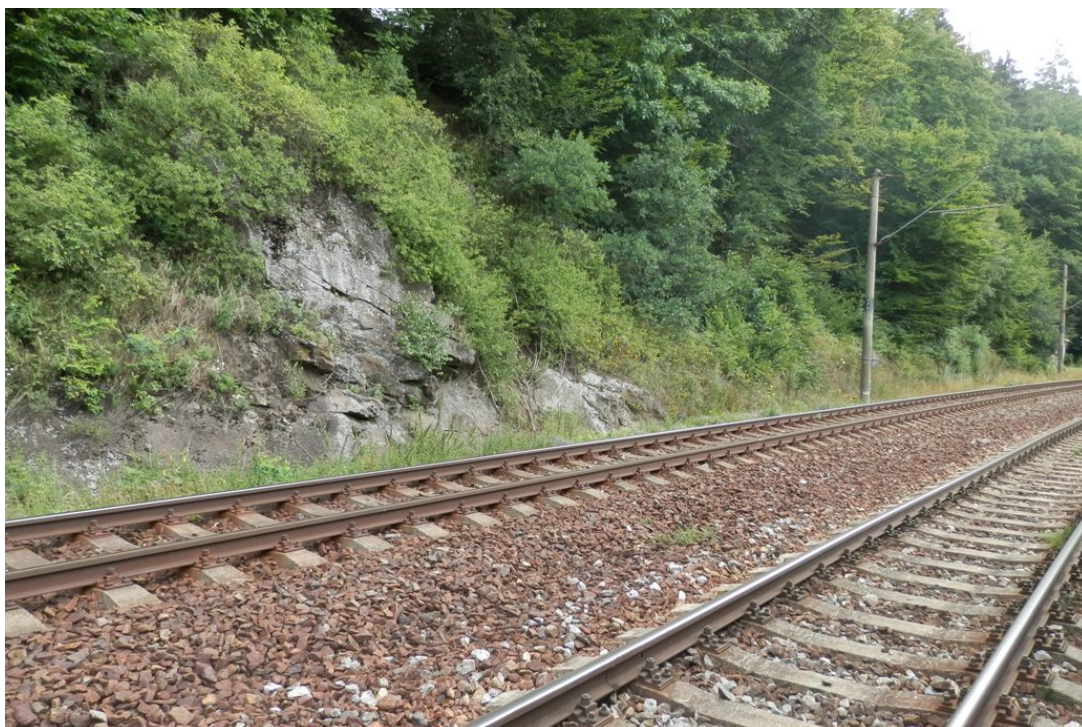
Obr. 12 Zvětralá pararula v odřezu u koleje č. 2 v km cca 237,900
