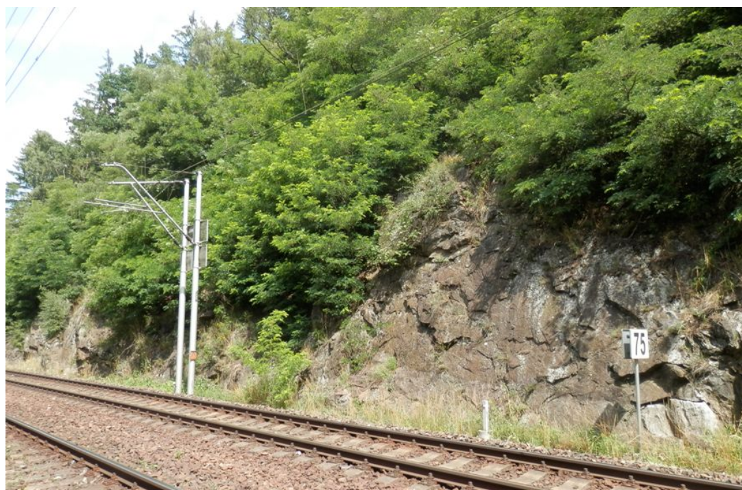
Obr. 8 Zvětralá pararula ve svahu odřezu u koleje č. 2 v km cca 236,500-550
