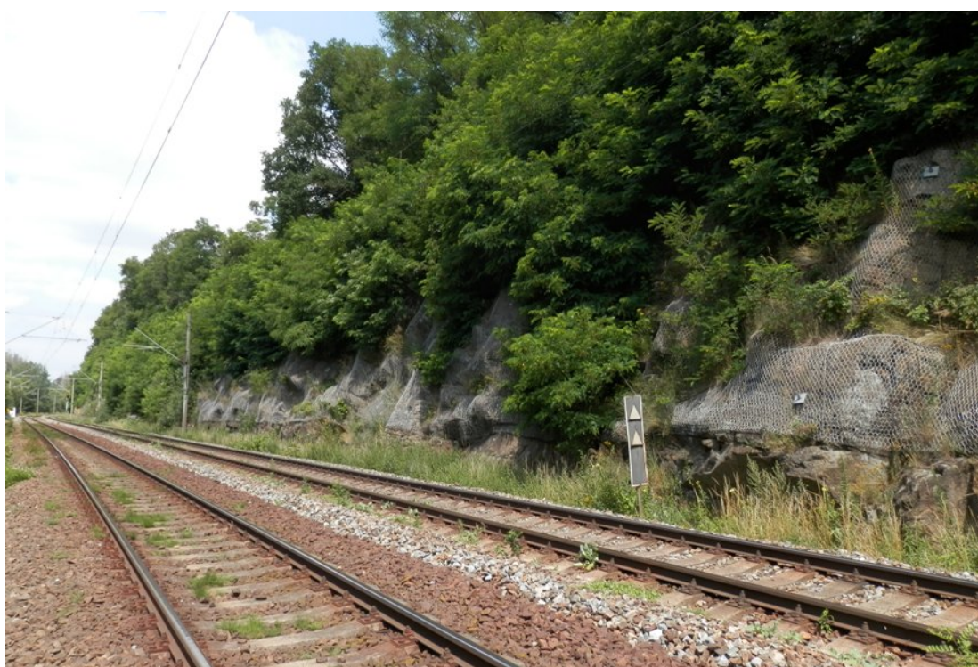
Obr. 6 Sanace svahu odřezu sítěmi u koleje č. 2 v km cca 235,700-850
